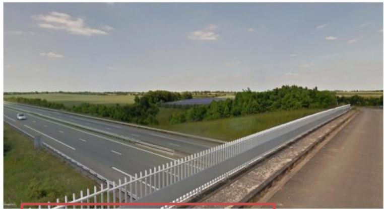
(Depuis le pont d'autoroute) Après réalisation du projet
